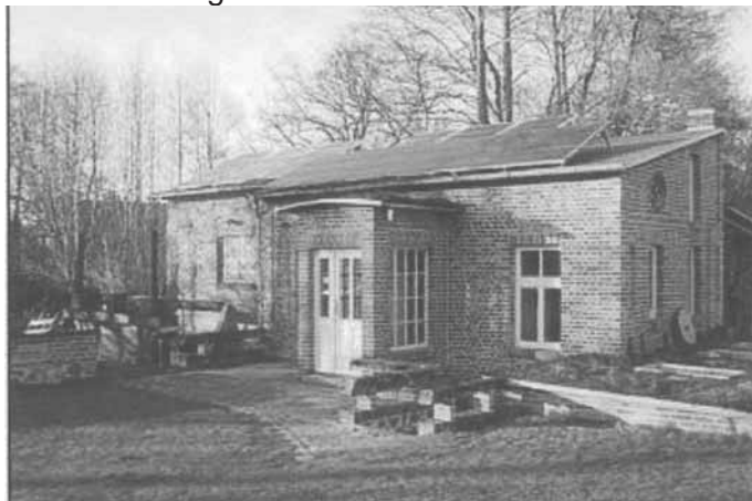
Wasserkraftwerk Aufnahme 2005 von Ingo Art 10
