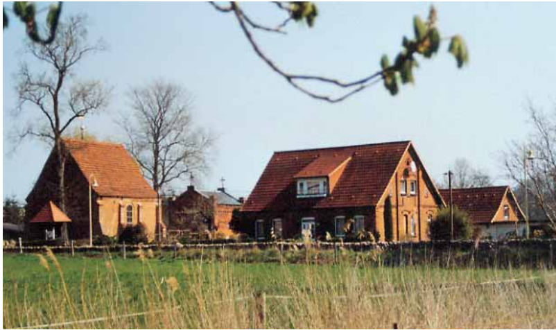
Kirche mit Glockenstuhl und alter Feierhalle, rechts (ehem. Lehrerhaus)
